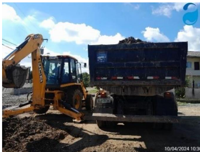
Figura 3 - Acondicionamento de resíduos no caminhão.
