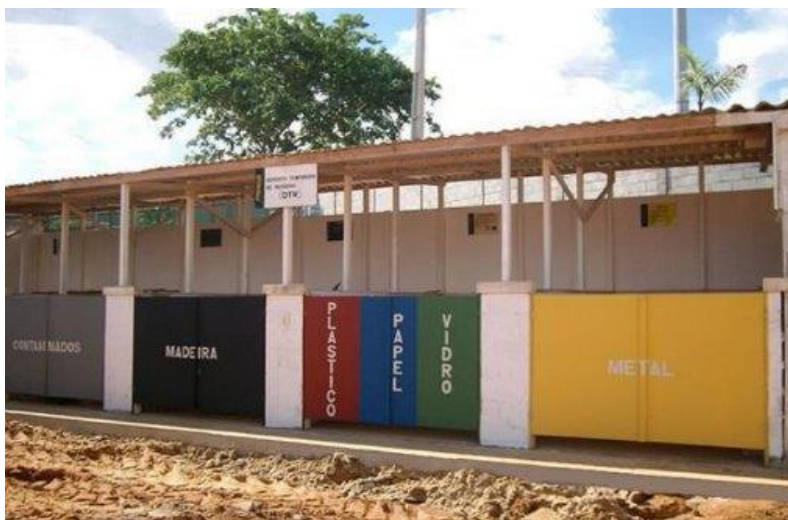
Figura 4 - Exemplo de baias de armazenamento de resíduos
